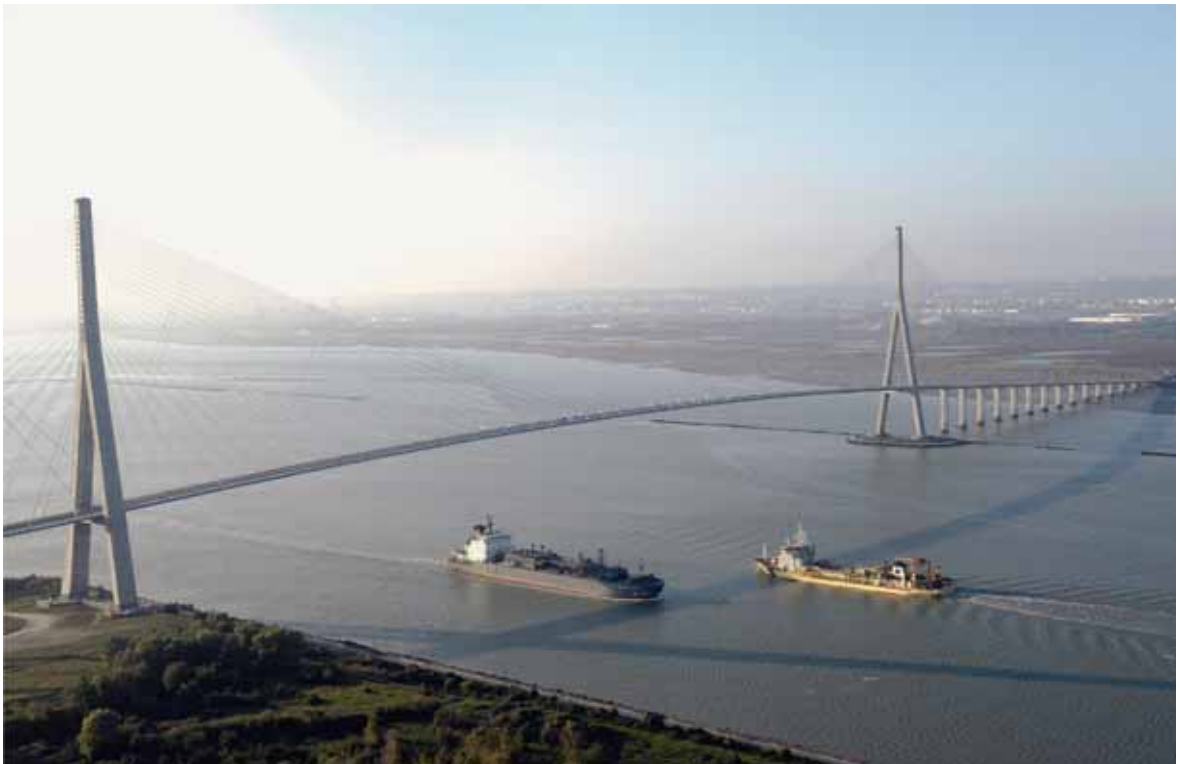
Pont de Normandie
